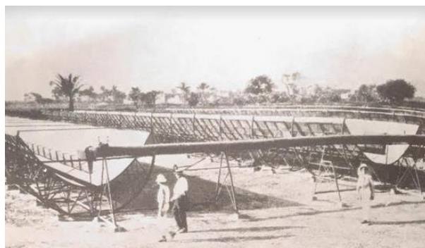
Ilustración 2.15 Vista sur del sistema de colectores de Shuman-Boys construido en Meadi, Egipto en 1913. Fuente: Meinel & Meinel, 1982
