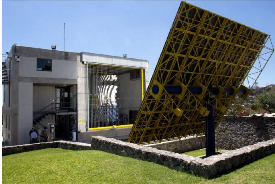
**Figura 18.** Horno Solar de alto flujo radiativo (HOSIER) en Temixco, México (LACYQS, 2018).
