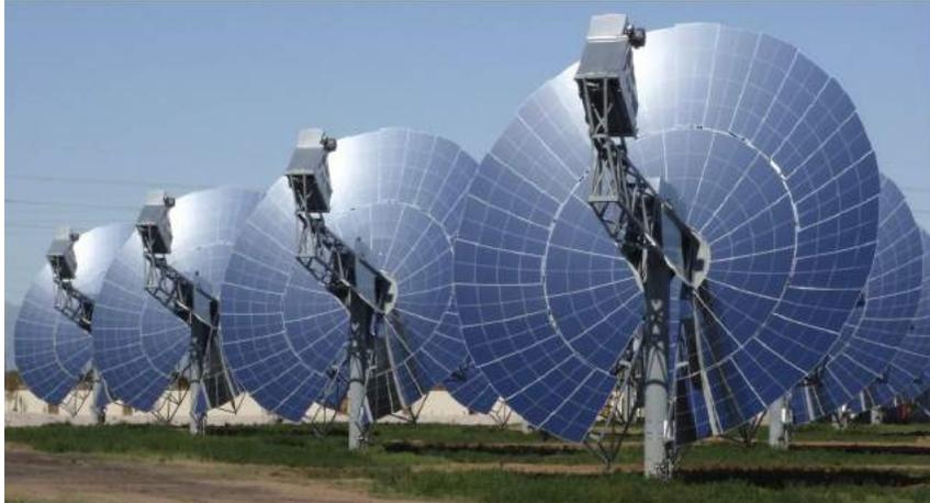
**Figura 8.** Planta solar de plato parabólico, Maricopa, Phoenix, Estados Unidos de América (Technology Power, 2018).
