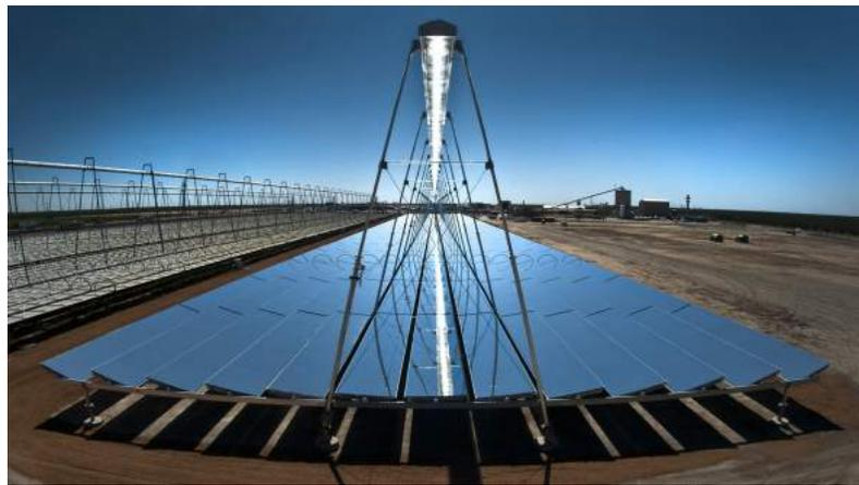
Figura 7. Planta solar tipo Fresnel. Areva Solar, Italia (Group Volumatrix, 2018).
