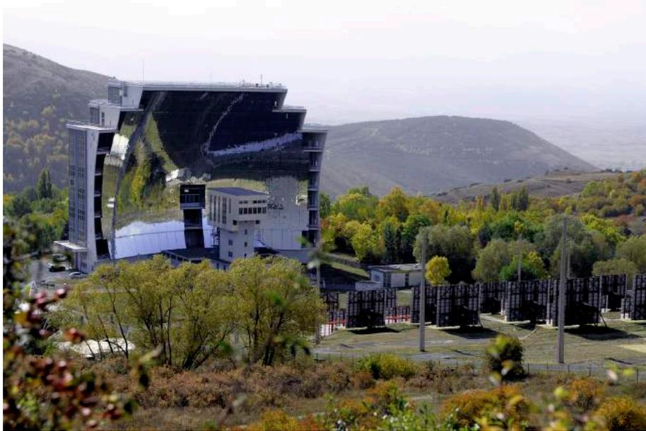
Figura 12. Horno solar de alto flujo radiativo en Odeillo, Francia (LACYQS, 2018).
