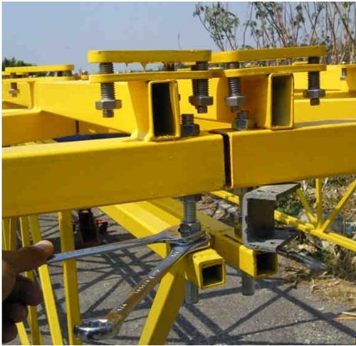
Fig. 4.6. Ajuste de altura de las facetas.
