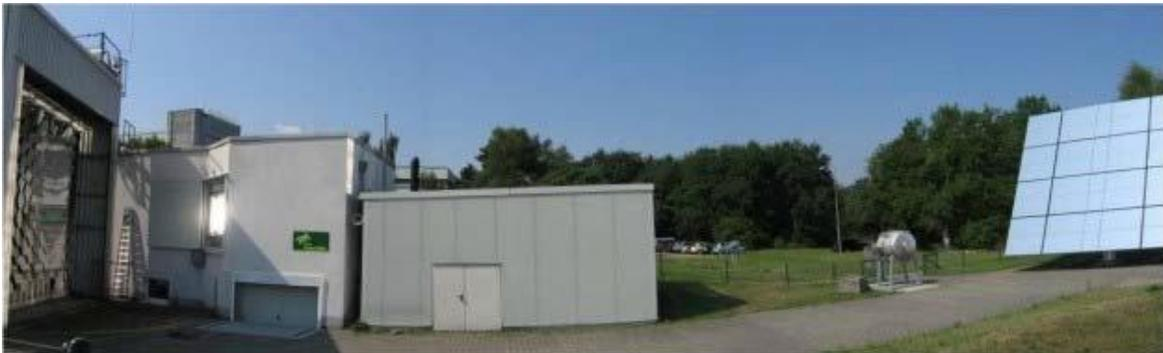
**Fig. 2.13.** Instalaciones del horno solar de Colonia, Alemania. De izquierda a derecha se observa: el concentrador, el laboratorio donde se encuentra el punto focal y el heliostato.
