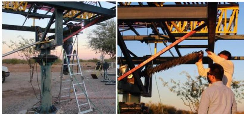
*Figura 48. acoplamiento actuador lineal en seguidor.*
