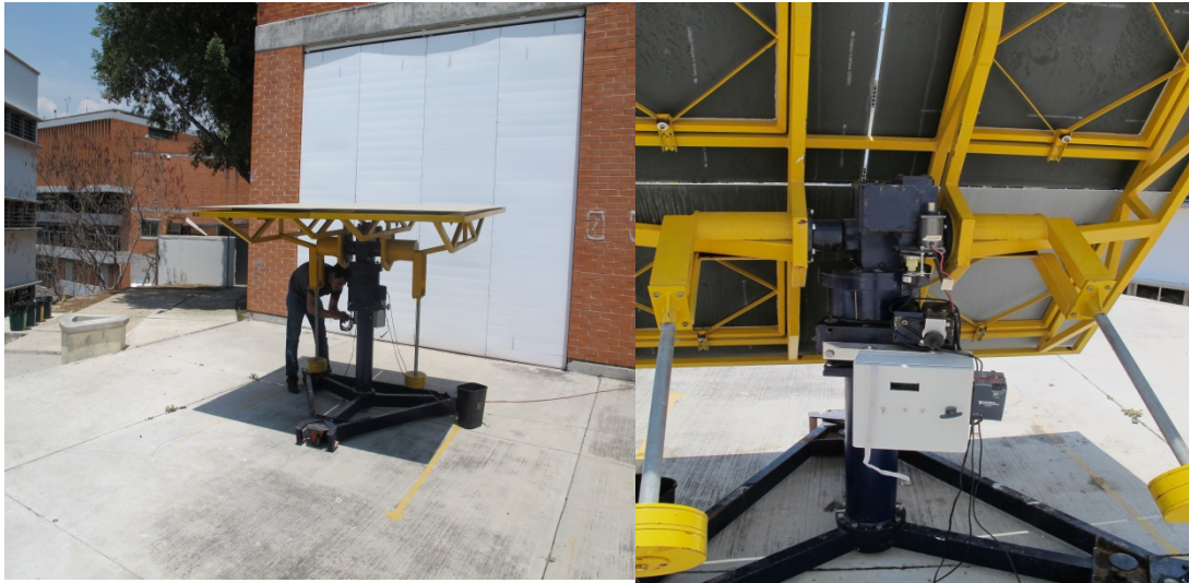
Figura 4. 16 Primera Etapa de montaje del sistema de control del Helióstato.
