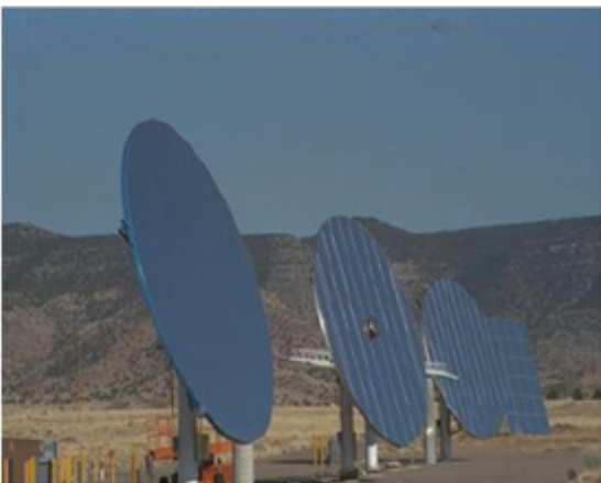
d) Helióstatos de membrana derecha
