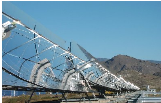
Figura 1.1 Canal Parabólico en planta solar de Almería, España.
