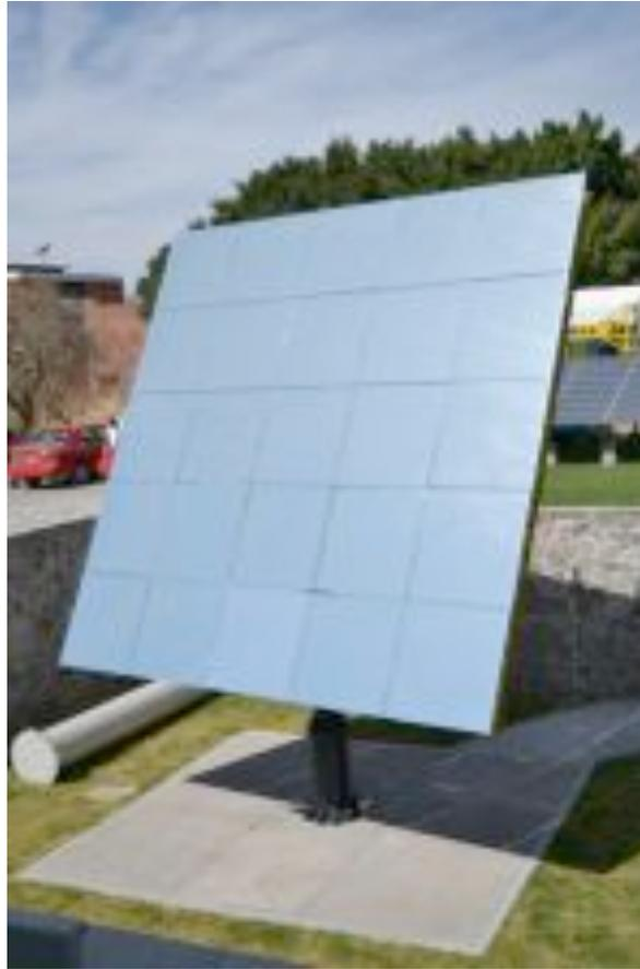
Fig. 3. Helióstato de 36 m<sup>2</sup> de 25 facetas alineadas en un mismo plano del HSAFR.
