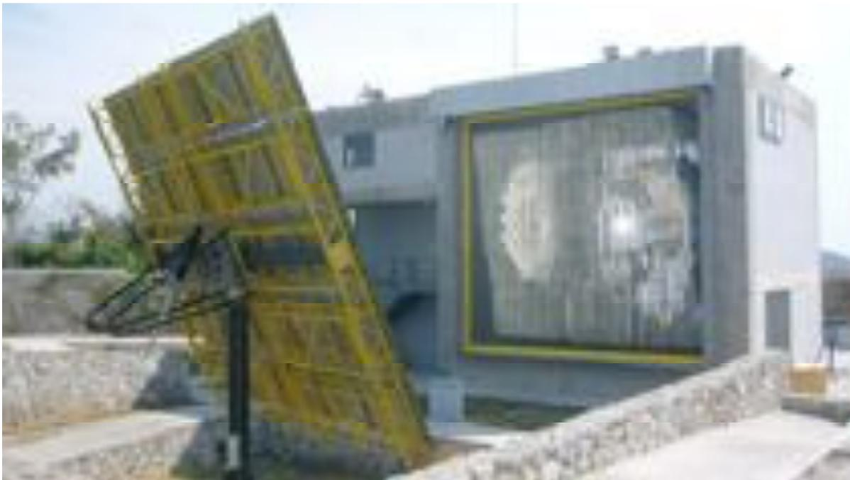
Fig. 1. Vista exterior del HSAFR donde se aprecia el heliostato, el atenuador y el concentrador.
