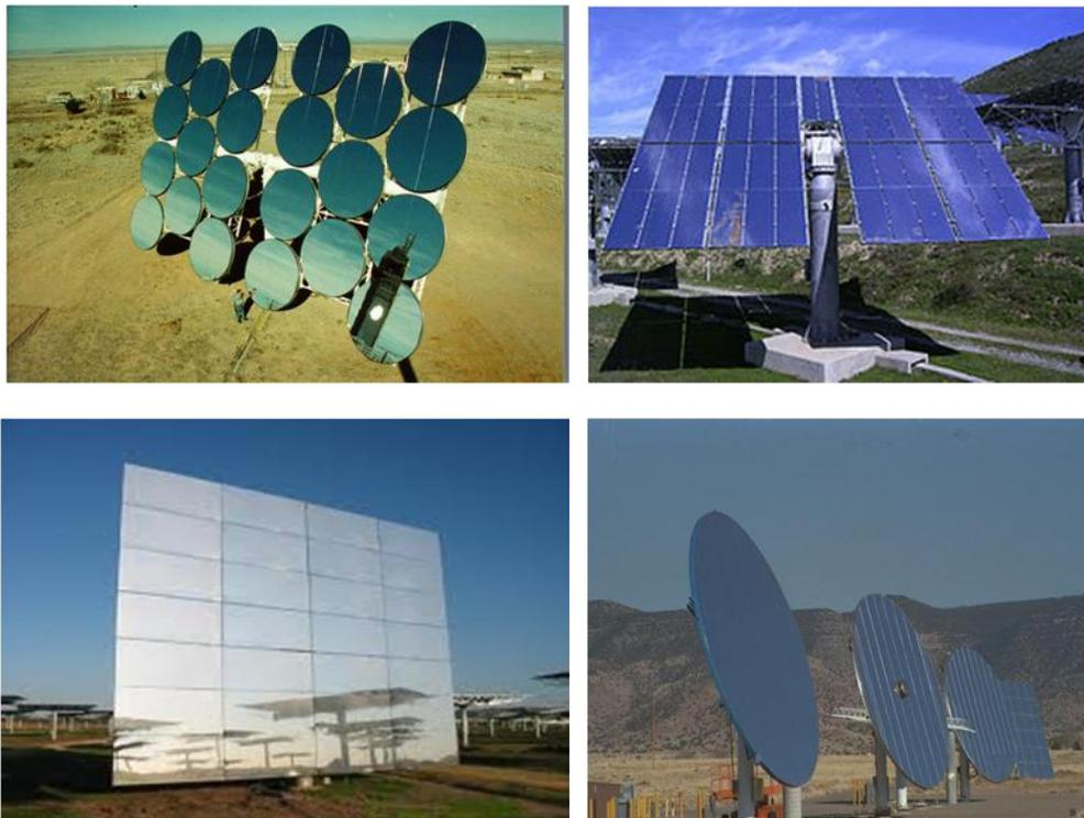
**Figura 2.4. Algunos tipos de heliostatos. Heliostato de facetas circulares cóncavas (superior izquierda), Heliostato de Herradura (superior derecha), Heliostato plano de múltiples facetas (inferior izquierda) y Heliostato de membrana estrecha (inferior derecha).**
