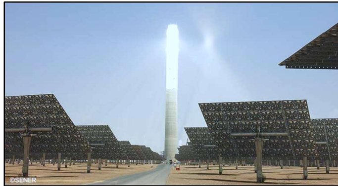
Figura 5. Sistema de torre central.
