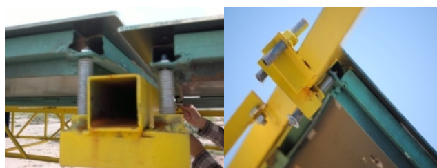
Figura 3.27: Sujeción y orientación de la faceta respecto el marco estructural(Elaboración propia).
