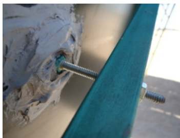
Figura A.1. 6: Elementos de ajuste central en el bastidor de la faceta (CEToC, 2013).
