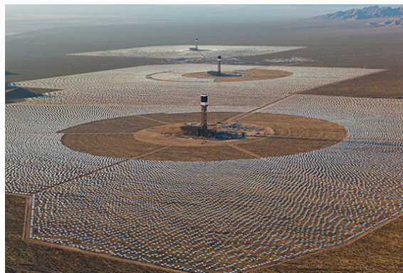
Figura 1.18: Planta Ivanpah Solar, California, USA. ( NREL, 2014)).
