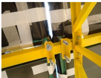
Figura A.1. 7: Espacio entre espejos de las facetas(CEToC, 2013).
