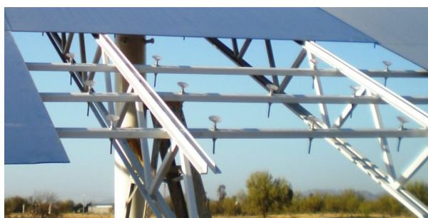
Figura 2.18: Sistema de sujeción y canteo de espejo del helióstato UNISON-TX-H36 (CEToC, 2008).
