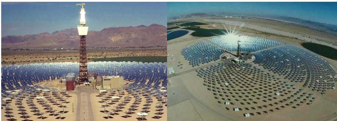
Figura 1.14: Planta Solar One, Barstow CA (Adaptado de: Solar One).
