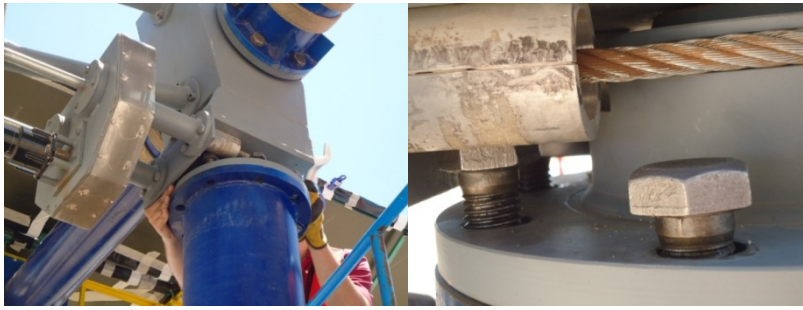
Figura A.1. 10: Instalación del cabezal sobre el pedestal (izquierda) y acoplamiento de bridas (derecha) (CETOC, 2013).
