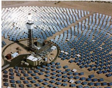
*Figura 1.7. Imagen de un concentrador solar tipo torre central, en la que se puede observar el campo de heliostatos y la torre central.*
