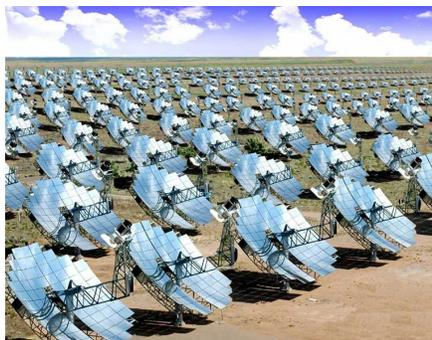
*Figura 1.8. Sistema de concentración solar tipo parque de platos Stirling.*
