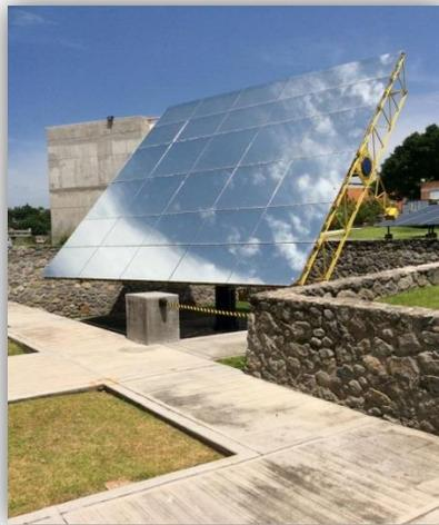
Figura 1.16: Helióstato H81 del HoSIER compuesto por 30 facetas.
