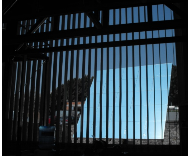
Fig. 1.8 Atenuador visto desde el interior del HSAFR.
