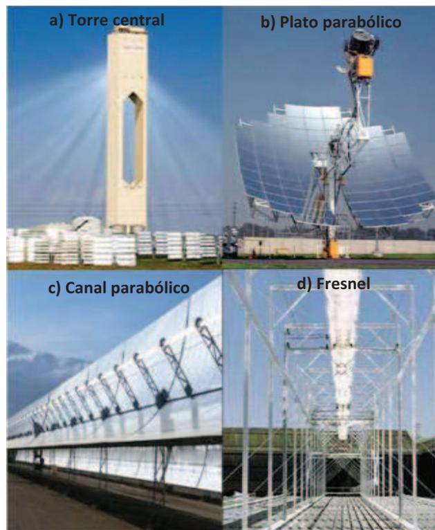
Figura 1.1 Tipos de sistemas de concentración solar
