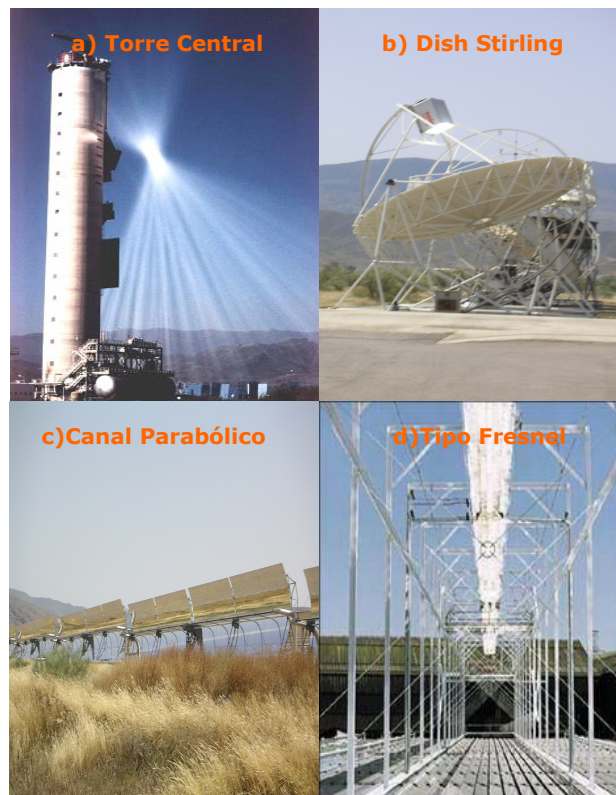
Figura 1.1. Diferentes tipos de sistemas de concentración solar operando de manera experimental en la Plataforma Solar de Almería (PSA), a) Sistemas de Torre Central (CESA), b) Sistemas Dish Stirling, c) Sistemas de Enfoque Lineal (DISS) y d) Sistema de concentración tipo Fresnel.
