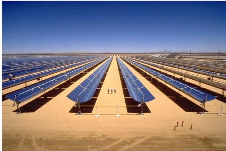
*Figura 1.4. Sistemas de concentración de reflexión. Tipo canal parabólico.(complejo de plantas SEGS en el desierto de Mojave, California, USA)*
