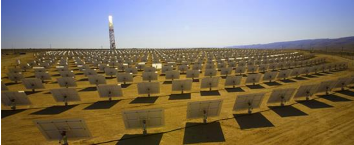
Figura 2.14 Planta Ivanpah Solar, California, EEUU (en construcción).
